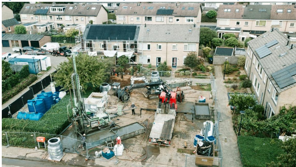
Figuur 7.2 – Materiaal benodigd voor gedeelde bodemlus boring in Terborg (foto: Itho Daalderop)
