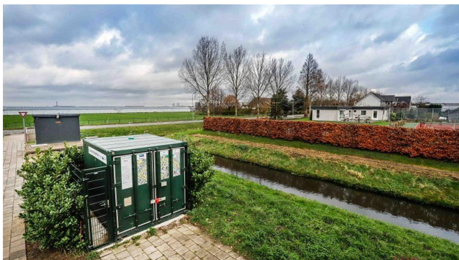
Figuur 7 - Voorbeeld van ruimtelijke inpassing van een buurtbatterij, Rijsenhout 2017
