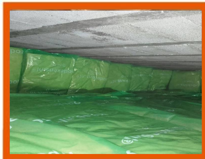
Isolatie met behulp van isolatiedekens
