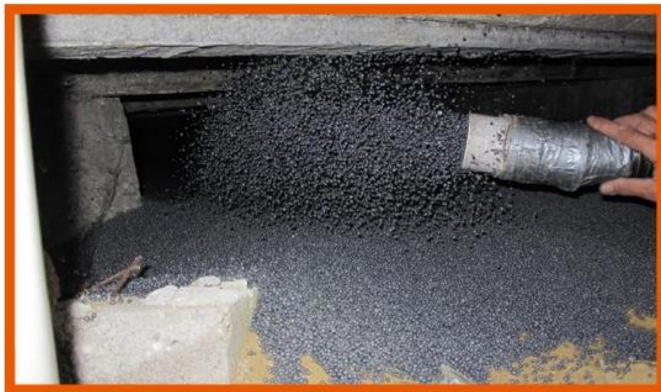
Bodemisolatie met behulp van EPS HR++Parels.
